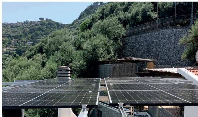
**Impianto Domestico** 3,2 kWp + accumulo da 4,8 kWh su struttura in ferro zincato. Massa Lubrense (NA).
