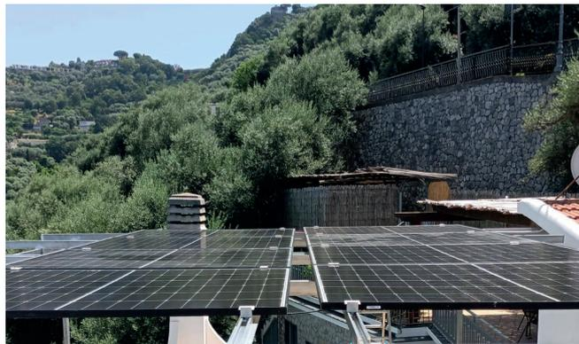
**Impianto Domestico** 3,2 kWp con accumulo da 4,8 kWh su struttura in ferro zincato, Massa Lubrense (NA)
