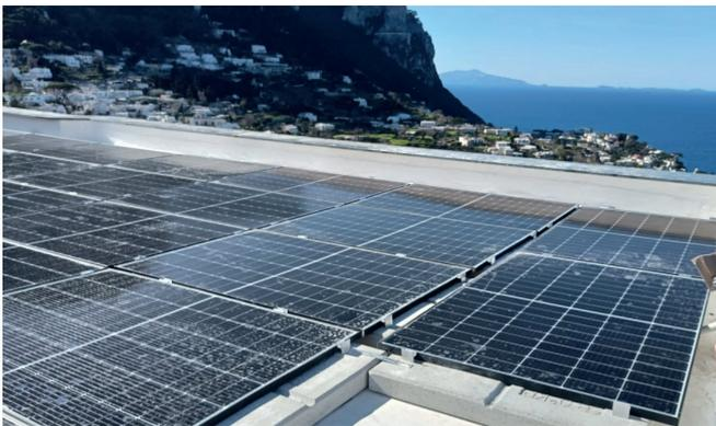
**Impianto Industriale** 18,5 kWp con sistema Sun Ballast, Capri (NA)
